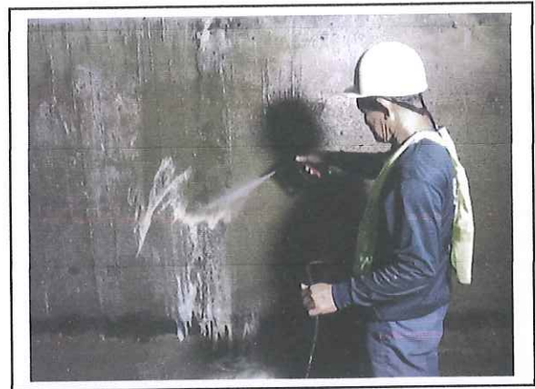
ขัดล้าง ด้วยเครื่องฉีดแรงดันสูง
